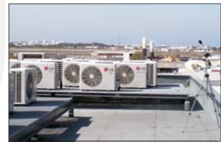
Ensayos de inmisión en cubierta
