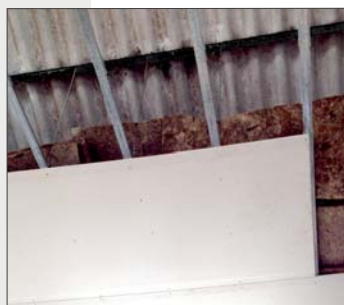
Techo edificios industriales
