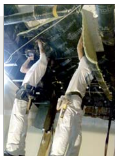
Aislamiento en forjado
