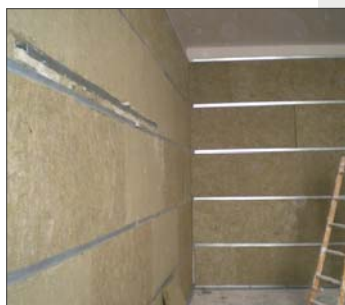
Aislamiento acústico de medianeras
