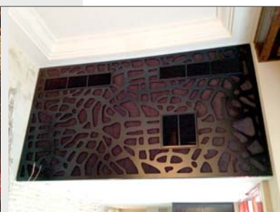
Panel decorativo fonoabsorbente: ejecución (izquierda) y acabado final (derecha)
