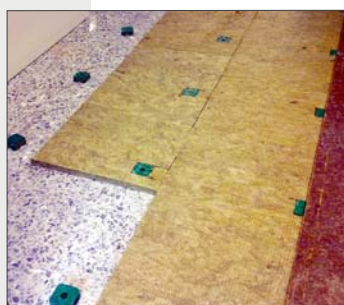
Ejecución suelo antiimpactos
