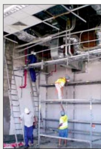
Demolición techo
