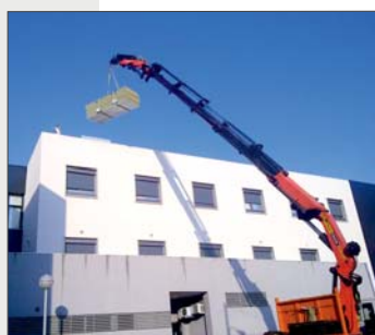
Elevación de material para pantalla
