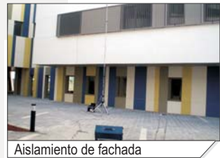
Aislamiento de fachada
